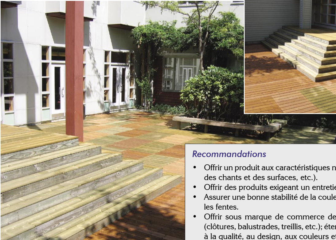
Plancher de terrasse à surface cannelée en essai au laboratoire de Forintek à Vancouver
